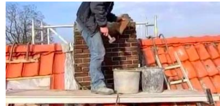
schoorsteen bouwen met bakstenen
